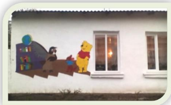
Оновлений фасад приміщення дитячої бібліотеки
